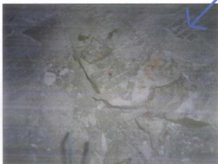
Visuels sur chape autour de tuyau ne contenant pas d'amiante et traces de colles contenant de l'amiante
