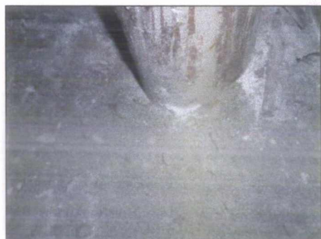
Visuels sur chape autour de tuyau ne contenant pas d'amiante et traces de colles contenant de l'amiante
